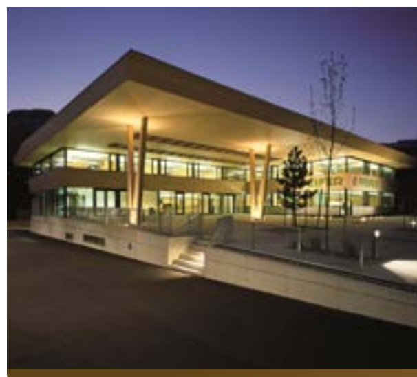
CONSTRUCTION EN BOIS POUR LE SIÈGE SOCIAL à Imst, dans l'Oberland tyrolien (A)
