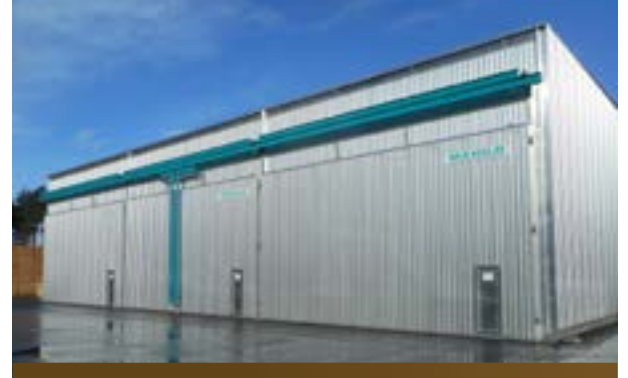
Nuove camere di essiccazione nello stabilimento di Uelzen
