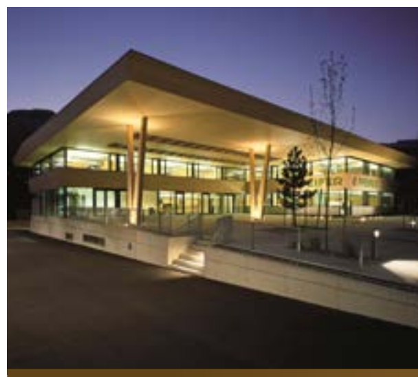
CENTRALA FIRMY DS. BUDOWLANYCH KONSTRUKCJI DREWNIANYCH
